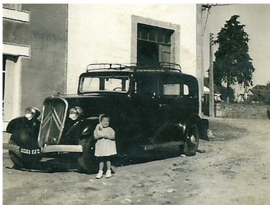
Photo 2 : Datée de 1949 et prise devant l'église et le commerce de Chiquet-Balès face à l'église du bourg d'Ergué-Gabéric. La petite fille est Michèle Balès née en mai 48. En partie supérieure de la photo, à la place de l'arbre, le bâtiment de la mairie n'est pas encore construit. À gauche, caché par le commerce Chiquet-Balès, il y avait la boulangerie Bihannic où l'on allait téléphoner.
